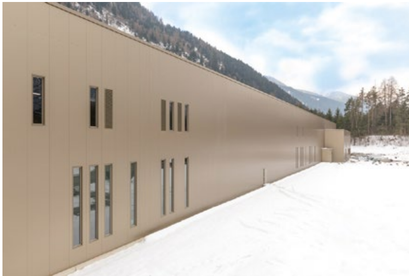
Die goldschimmernde Fassade der neuen Speck-Produktionshalle von Handl Tyrol.
