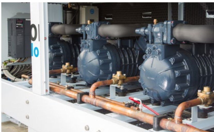
Die drei eingesetzten Dorin-Verdichter – der linke ist frequenzgeregelt. Im Hintergrund ist der Inverter zu sehen.
