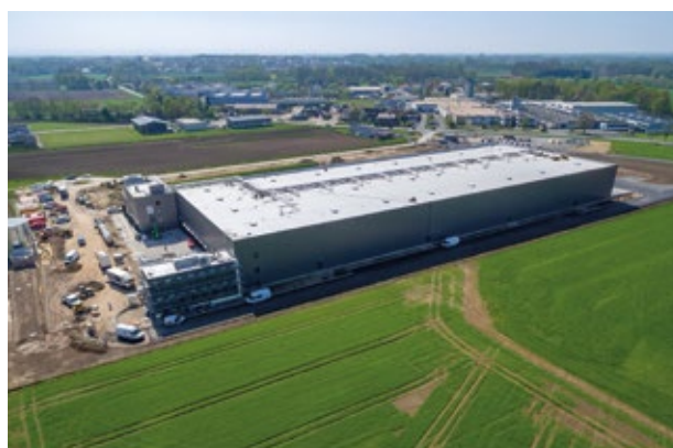
Kühlmann errichtet sein neues Logistikzentrum auf einem 75 000 Quadratmeter großen Grundstück in Westenholz.
