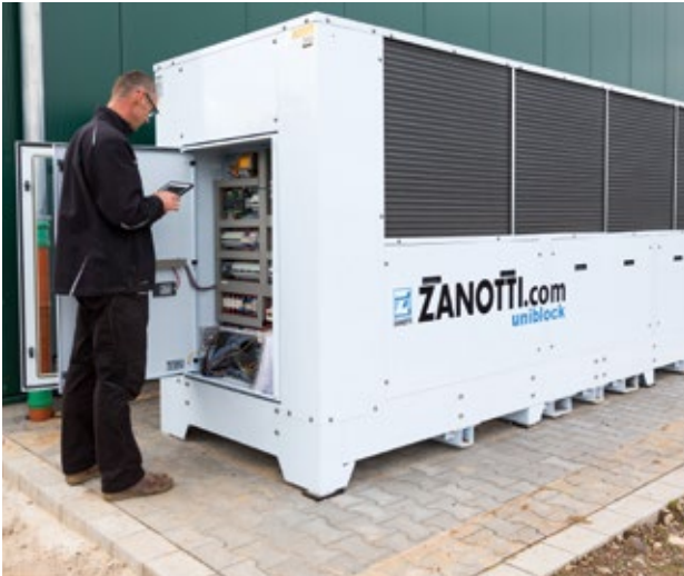
Die Inbetriebnahme-Unterstützung vor Ort erfolgte durch Jörg Erdmann vom Daikin Field Service.
