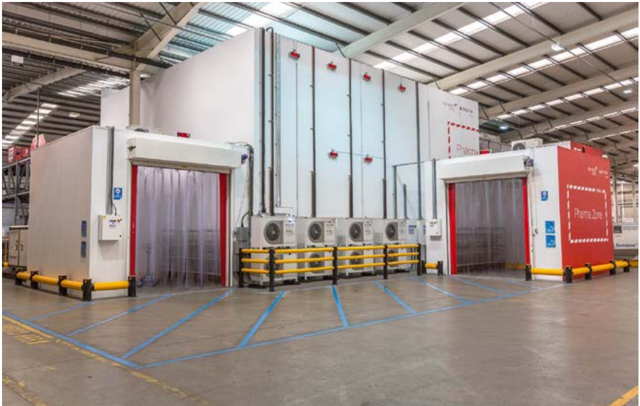
Teil der neuen Pharmaanlage sind zwei begehbare Kammern, die die Temperaturbereiche 2 bis 8°C und 15 bis 25°C einhalten können.
