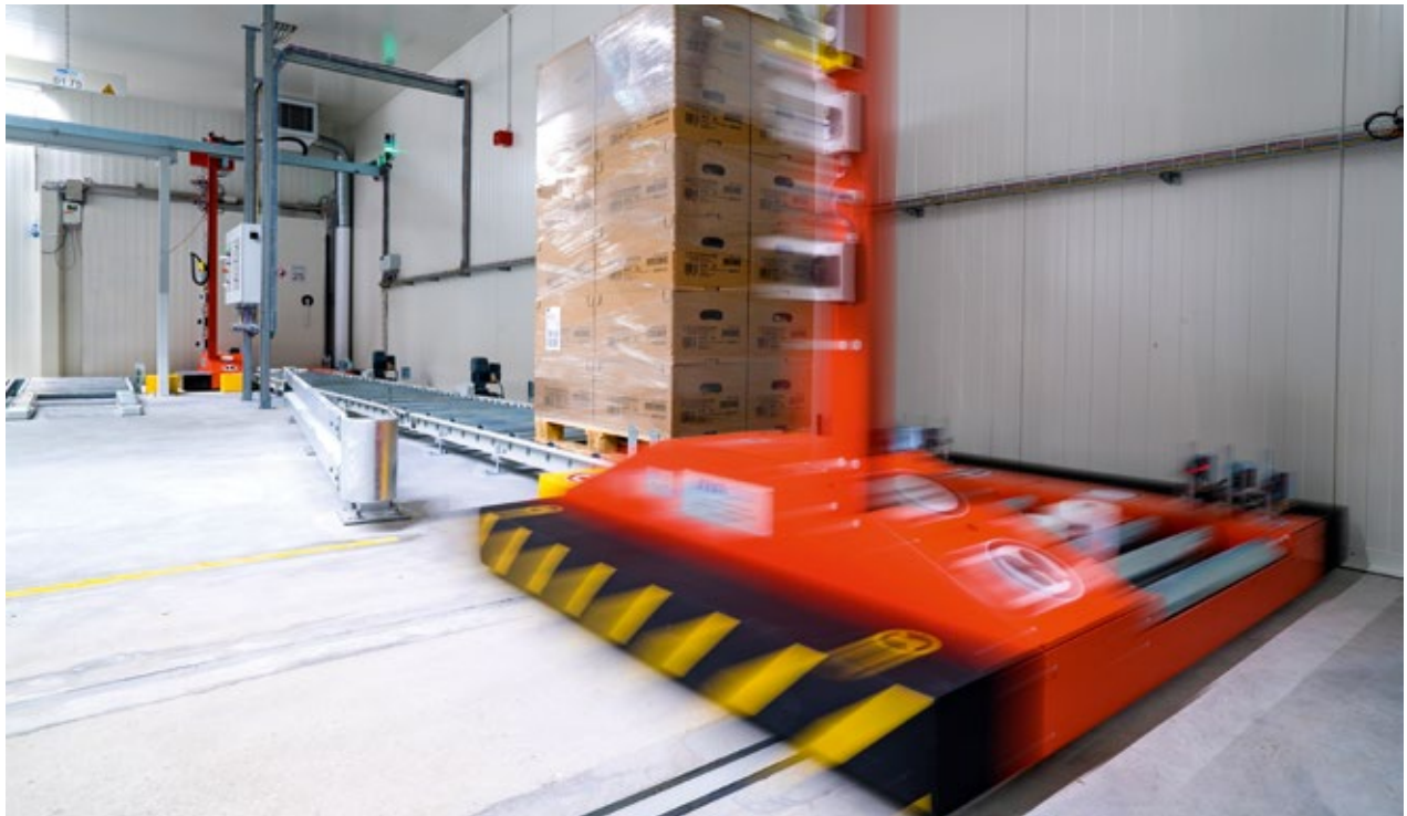
Transferwagen transportieren die Paletten aus dem Lager in den Kommissionierbereich, wo sie den vorgesehenen Pickplatz per Schwerkraftrollenbahnen erreichen.
