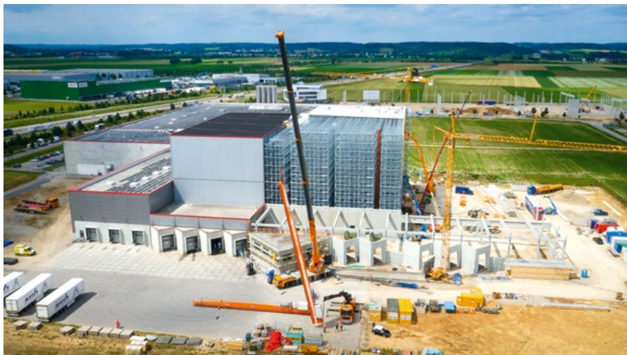
Einbringung der Regalbediengeräte in das neu errichtete TK-Hochregallager für einen Backwarenhersteller.
