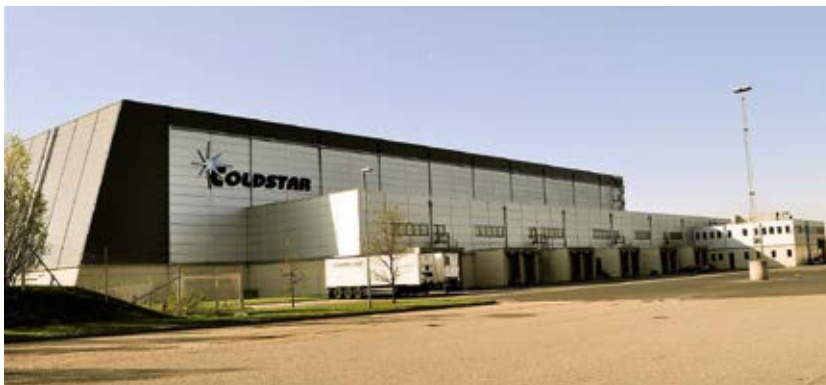
1998 wurde das automatische Tiefkühl-Hochregallager von Coldstar in Vejle in Betrieb genommen
