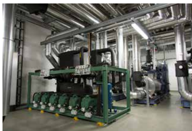
Die CO 2 -Anlage arbeitet ausschließlich im subkritischen Bereich und besteht aus einem Verbund von sechs Kompressoren, die jeweils eine Kälteleistung von 65 kW haben.
