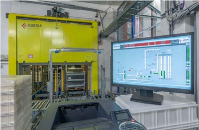
Moderne Steuerungstechnik führt jetzt den operativen Betrieb der Gesamtanlage.
