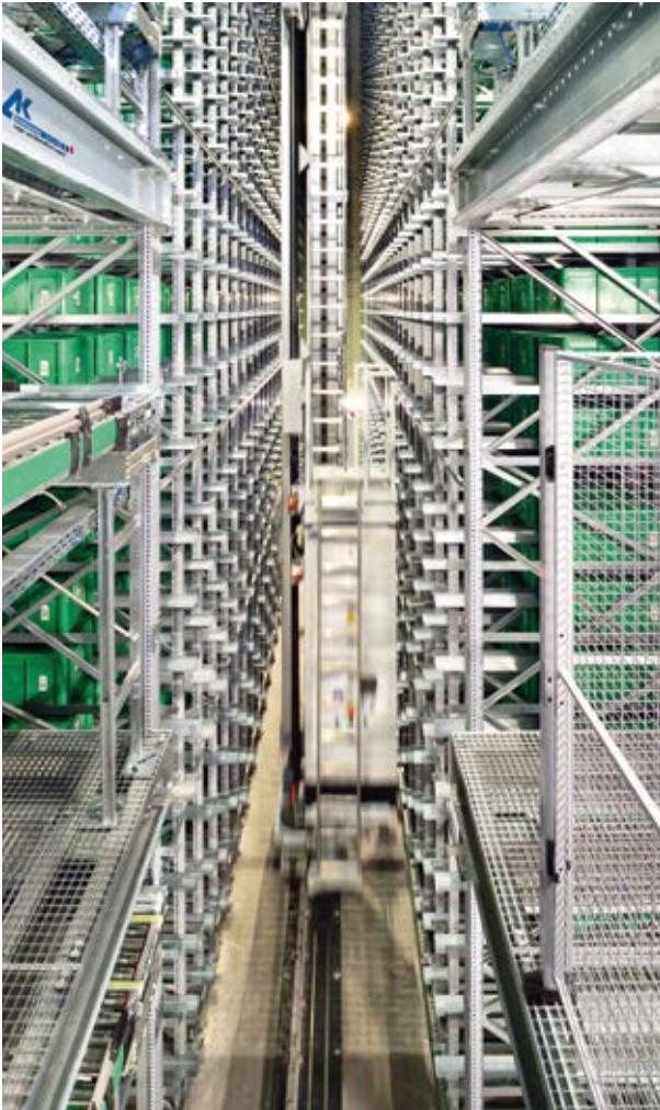
Das zweigassige automatische Kleinteilelager fasst 8800 Behälter.
