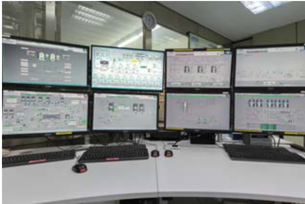
Die Basis der homogenen Lösung ist Simatic WinCC V7, ein für verschiedene Endgeräte offenes System, das alle Prozesse visualisiert alle Prozesse und damit deren Kontrolle und Optimierung erleichtert.
