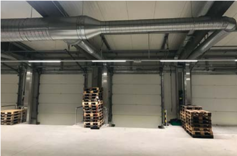
Die Luftwandtechnik soll auch eine barrierefreie Sicht und Zufahrt für Anliefer-LKW ermöglichen.
