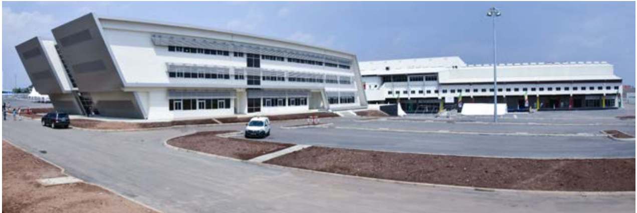
Außenansicht Luftfrachtterminal in Addis Abeba: Verwaltung und landseitige Verladung.
