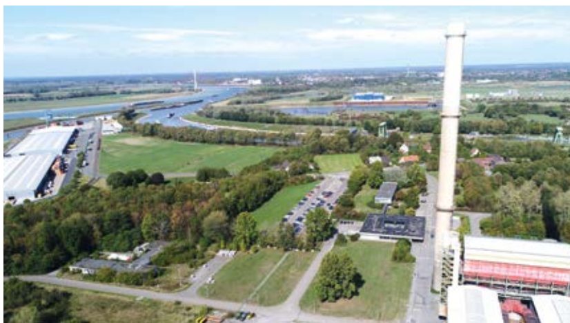
Kooperation am Rhein: Im Hafen Emmelsum bietet die Trimet Aluminiumhütte Abwärme zum Beispiel für Kühllogistikanwendungen.
