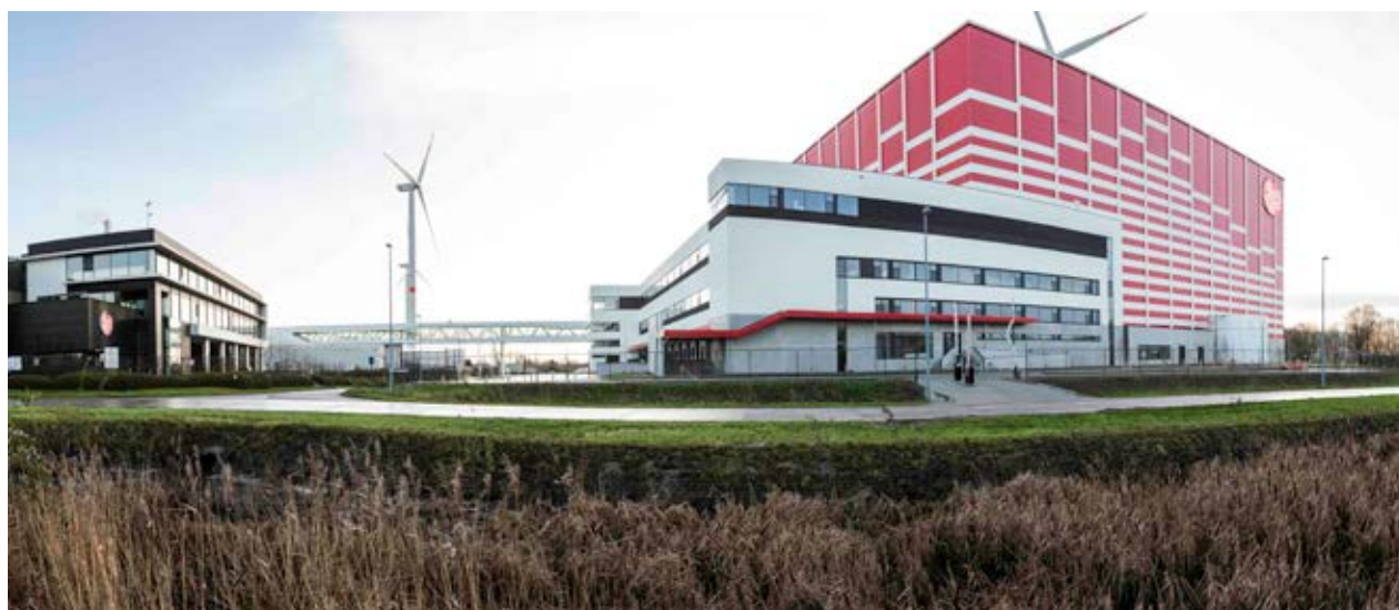
Eine 100 Meter lange überdachte Förderbrücke verbindet beide Hallen bei Poco Loco.
