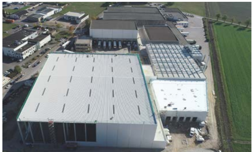
Die im Bau befindliche Nordfrost-Erweiterung in Versmold soll im Mai kommenden Jahres den Betrieb aufnehmen.
