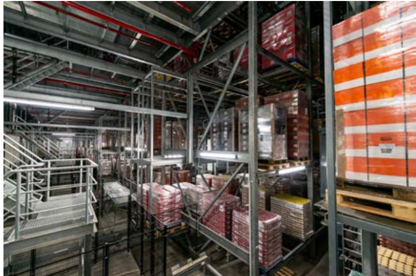
43 000 Paletten finden in dem bei Poco Loco installiertem System Platz.
