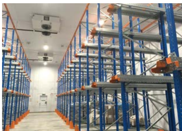
Wird mit Opteon XL40 von Chemours gekühlt: das 1805 Kubikmeter große Tiefkühlager von Park Cakes Bakery.
