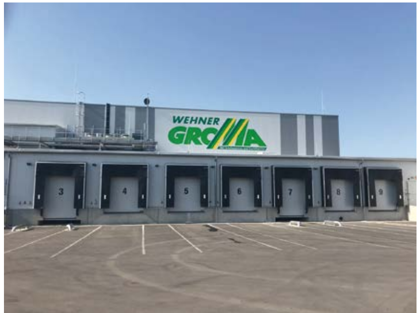
Bei Wehner Gronau arbeitet eine Luftwandanlage, die sieben Tore abschottet.
