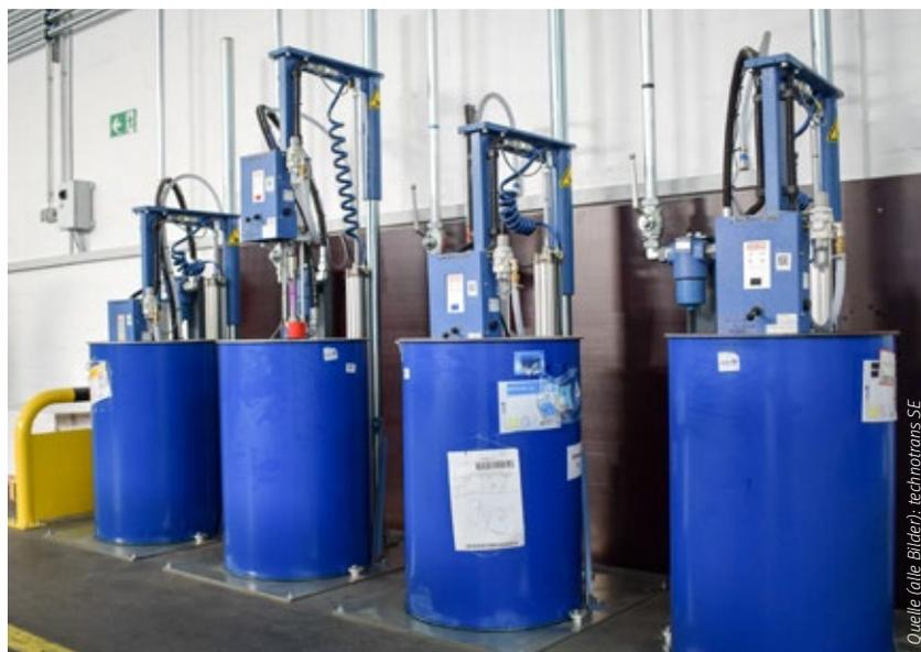
Technotrans installierte zunächst eine neue Farbversorgungsanlage, die WB Verpackungen den Einsatz von 200-Kilogramm-Fässern erlaubt.
