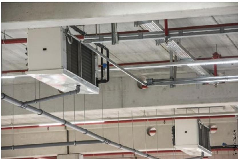
Jedes Zeas-System ist an zwei Verdampfer angeschlossen.
