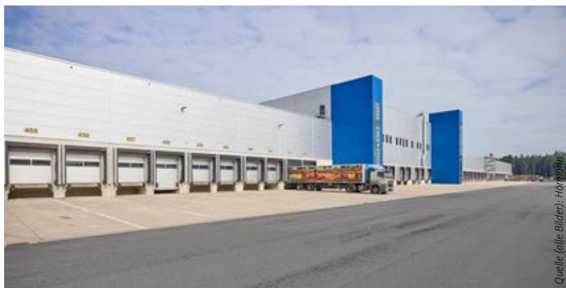
Alle Verladestellen am Edeka-Lager sind mit Verladetechnik und Industrie-Sektionaltoren von Hörmann ausgestattet.
