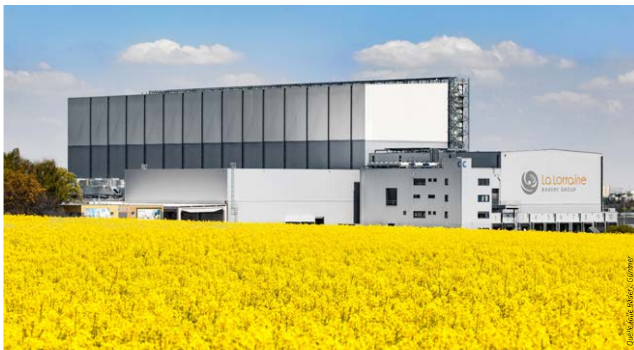
Für das neue vollautomatisierte Hochregallager von La Lorraine im tschechischen Kladno lieferte Güntner Kühler und Plattenwärmeübertrager.
