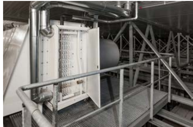
Standardmäßig ist bei Güntner Highstore Application Luftkühlern über eine Wartungstür ein guter Zugang von beiden Seiten des Luftkühlers gewährleistet.
