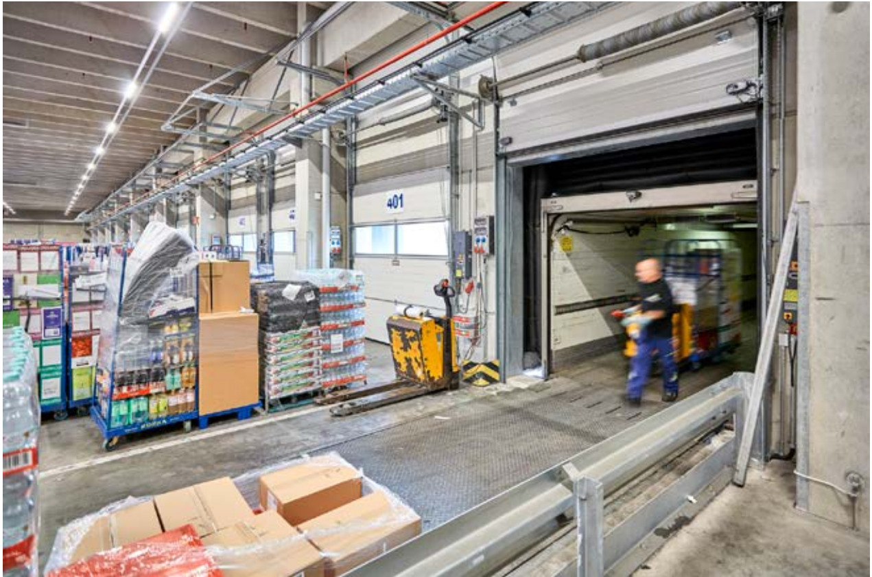
Hydraulische Vorschub-Ladebrücken von Hörmann gleichen auch große Höhenunterschiede vom Rampenniveau bis zur LKW-Ladefläche aus.
