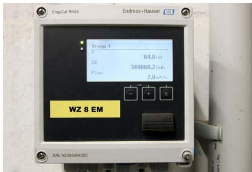
Ein Messgerät erfasst die von den Kompressoren zurückgewonnene Wärmeenergie, die im Werk als Prozesswärme sowie zum Heizen genutzt wird.
