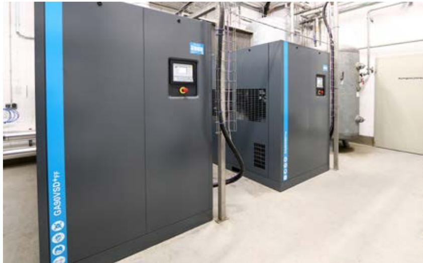
In der modernisierten Kompressorstation stehen drei drehzahlgeregelte Schraubenkompressoren des Typs GA VSD+ FF – zwei mit 90 kW Leistung (hier im Bild) sowie einer mit 55 kW, der hinter der Tür in einem kleinen Nachbarraum steht.
