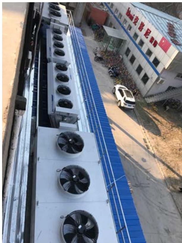
*Oben und unten im Bild: Güntner Flat Vario Tischgas-kühler vom Typ GGHV, die für die erste Stufe der CO<sub>2</sub>-Abkühlung und einen Wärmerückgewinn sorgen, indem das Heißgas bei dieser Auslegung von 121 bis 103 °C auf 41 °C abgekühlt wird.*
