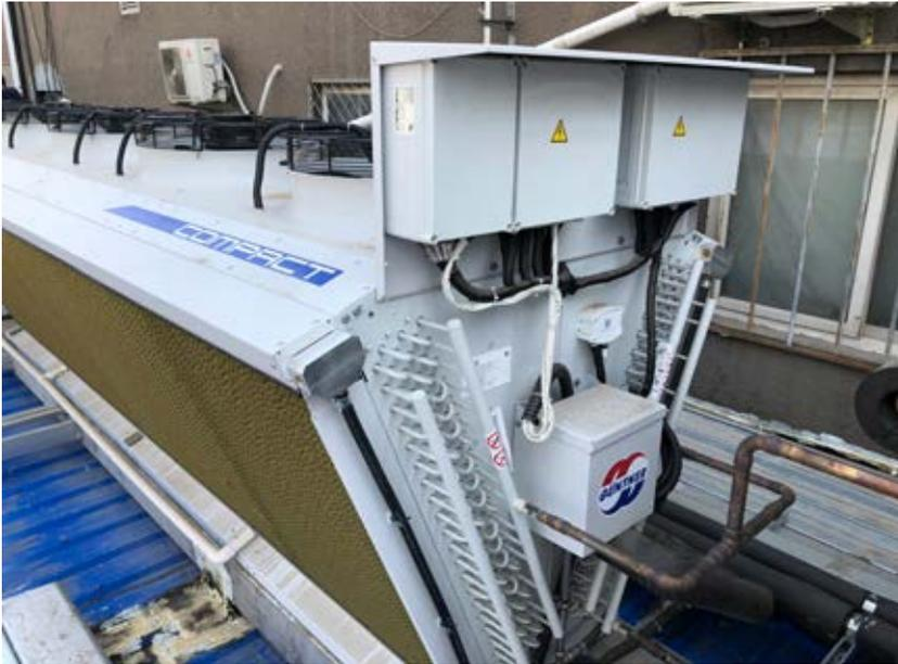
Ein Güntner V-Shape Compact Verflüssiger Typ GGDC wird bei Außentemperaturen über 20°C besprüht und sorgt bei dieser Auslegung zuverlässig für die Abkühlung des CO<sub>2</sub>-Heißgases von 41°C auf 34°C.
