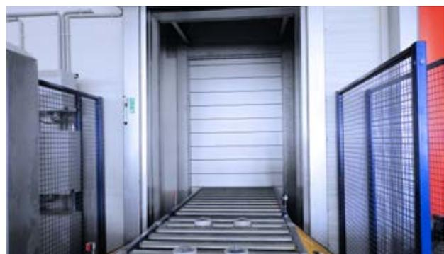
Sechs Tiefkühl-tore EFA-SST-TK-100 sind in der Produktions-anlage in Mélykút installiert.
