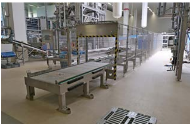
Die Anlage sichert die kontinuierliche Ver- und Entsorgung der vollautomatischen Füllstation am Teigkneiter.
