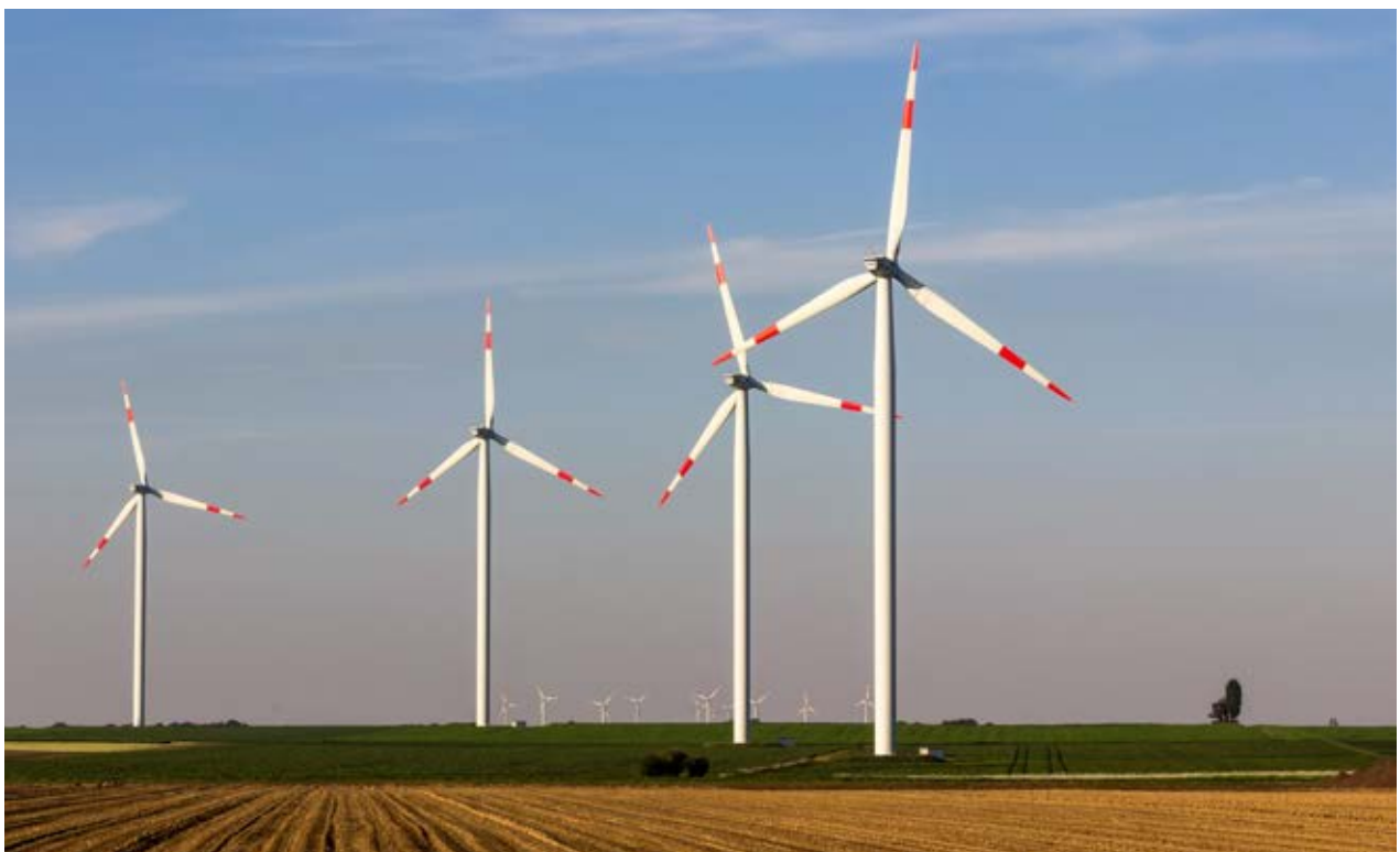
Der klimaneutrale VDKL-Strompool startet 2020
