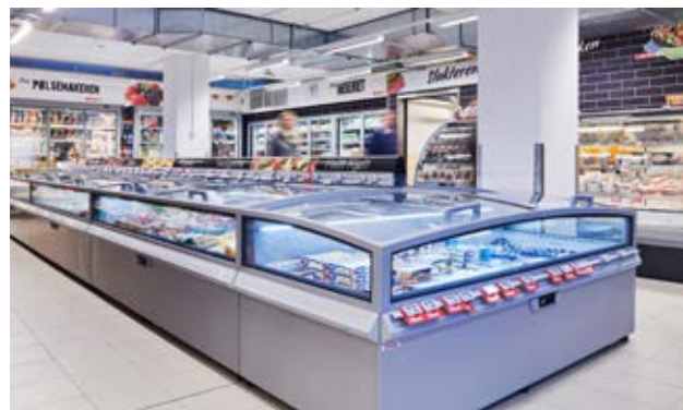
Unter anderem das Daikin-Tochterunternehmen AHT Cooling ist in Düsseldorf mit dabei.
