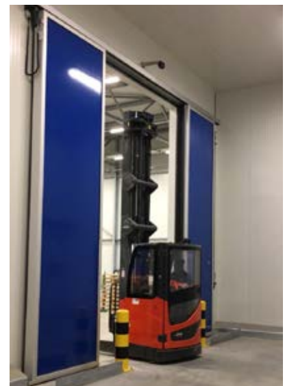
Die nahtlosen Türblätter der zweiflügeligen Türen von Salco sind mit einer isolierenden Kernfüllung ausgerüstet.
