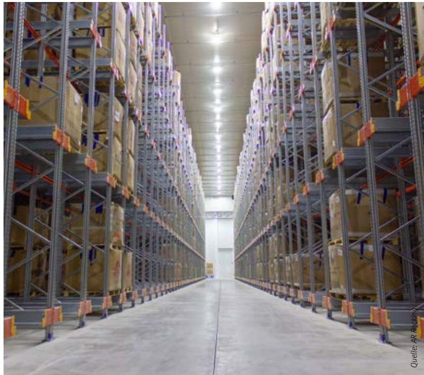
10 520 Stellplätze für Europaletten: Die spanische Virto-Gruppe lagert Tiefkühlgemüse bei -24^{\circ}\text{C} in Regalen von AR Racking.
