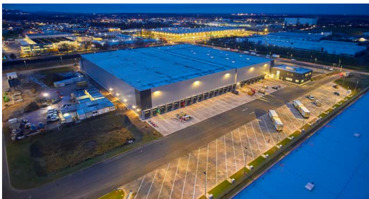
Das neue Distributionszentrum von Havi in Wunstorf bei Hannover.
