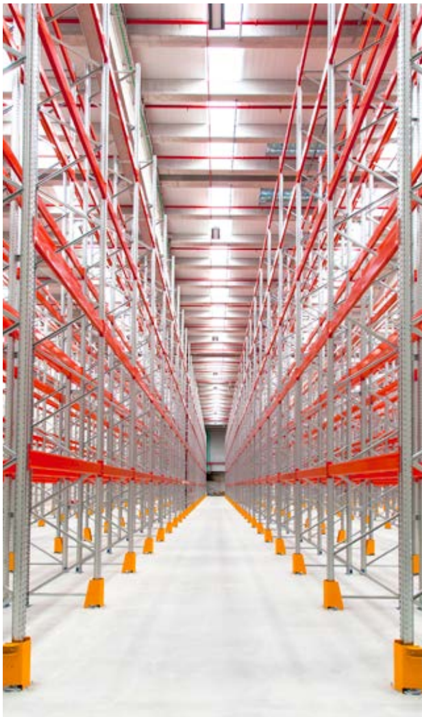
Das System AR PAL ist in Höhe, Breite und Länge flexibel installierbar.
