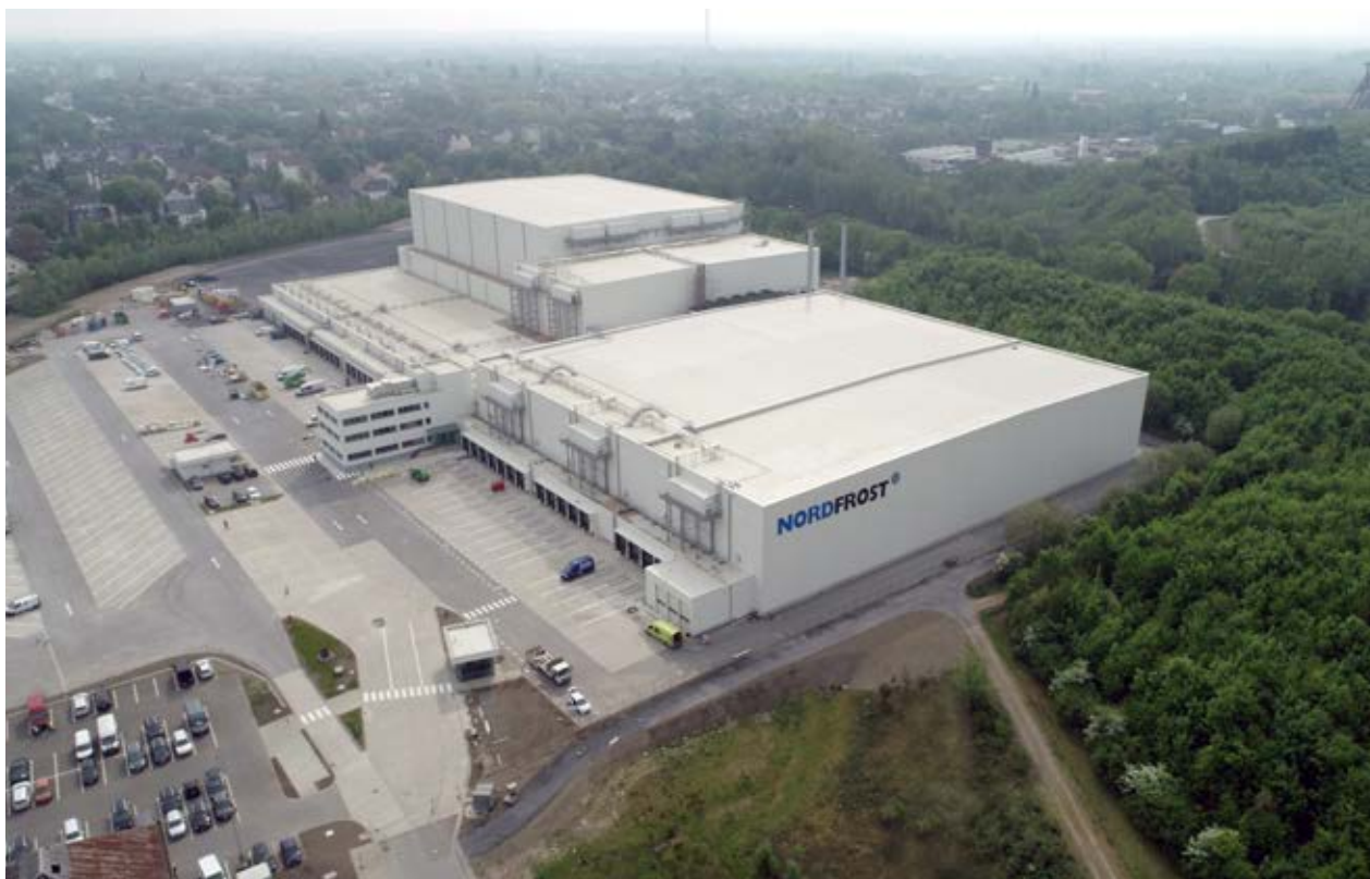
Der neue Nordfrost-Standort in Herne von oben.
