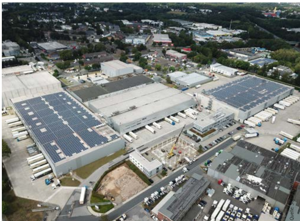
Auf zwei Dächern des Nagel-Standorts Bochum wurden mehr als 8000 PV-Module installiert.
