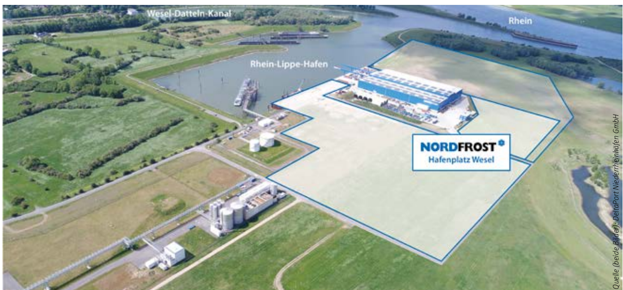
Im Rhein-Lippe-Hafen Wesel siedelt sich die Nordfrost mit einem modernen, multifunktionalen Logistikzentrum und eigenem Schiffsumschlag direkt an der Kaikante an.
