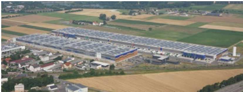
Die Aufdach-Solaranlage des Multicube Rhein-Neckar.
