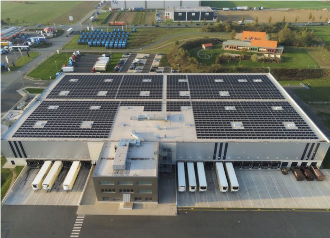
Auf dem Dach des Nagel Frischelogistikzentrums Bochum produzieren 8000 Solarmodule den Strom genau dort, wo er gebraucht wird.
