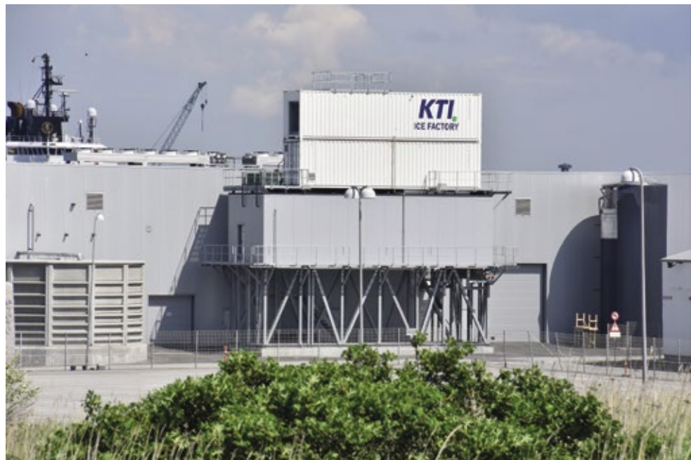
KTI integrierte die Anlagen zur Eiszerzeugung in handelsübliche Hochseecontainer.
