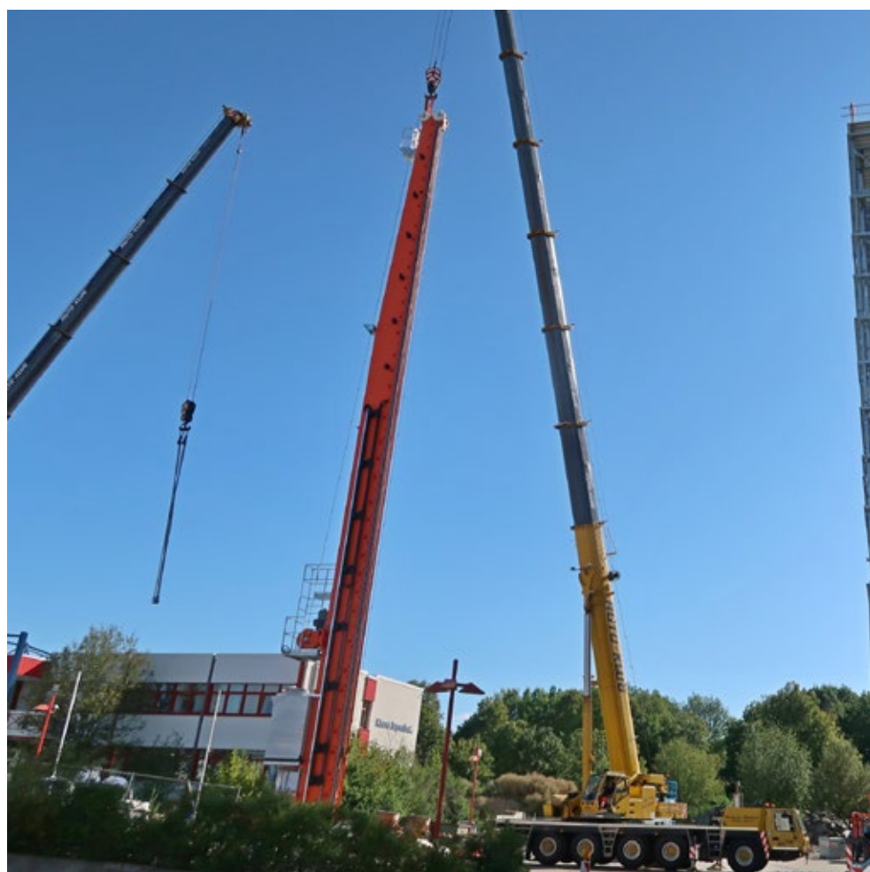
Ein Autokran hebt das Regalbediengerät über das Dach in den Lagerneubau.
