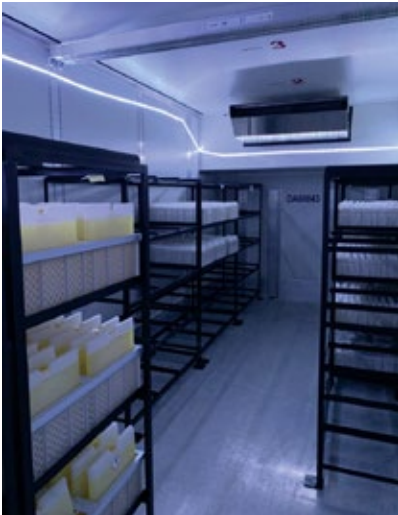
Zur Rekonditionierung der Kühlakkus platzierte Dachser eine Thermowechselbrücke in der Lagerhalle.
