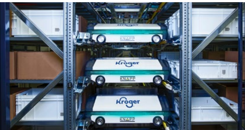
Das OSR Shuttle Evo stellt die Lebensmittel in der exakten Reihenfolge für die Kommissionierung zur Verfügung.
