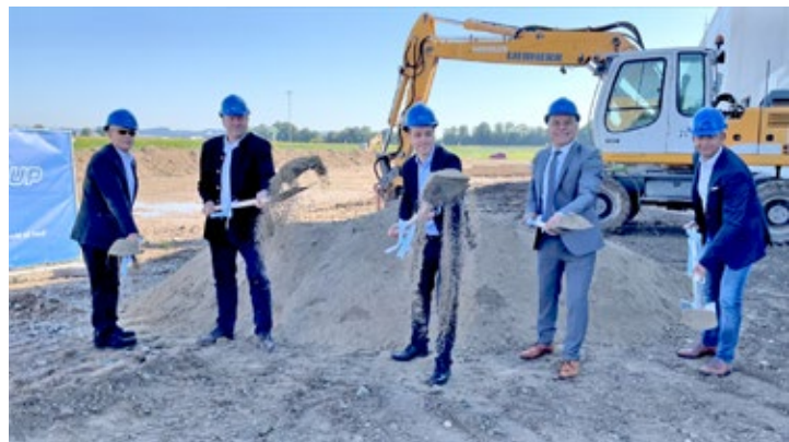
Beim ersten Spatenstich in Buxheim (von links): Projektleiter Karl Sigloch, Jürgen Unglehart vom Generalunternehmer Unglehart GmbH, Christian Berlin, Executive Director Logistics bei der Nagel-Group, Buxheims Erster Bürgermeister Wolfgang Schmidt und Mischa Kortner, der die Niederlassung Buxheim leitet.
