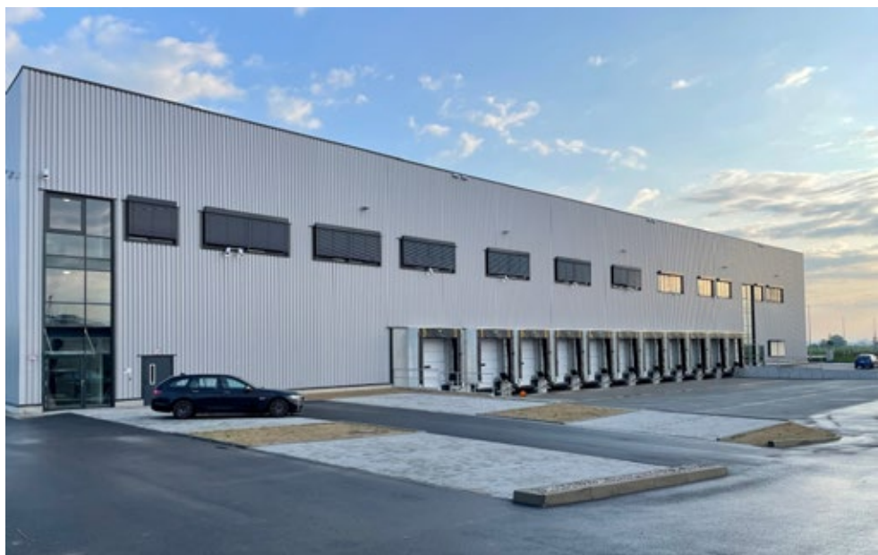
Das Logistikzentrum von Frigo-Trans in Mutterstadt.
