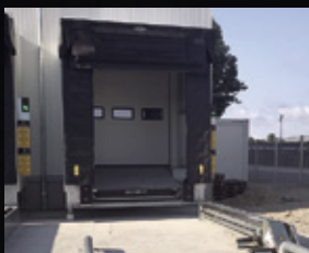
Isolierte Verladeschleusen
