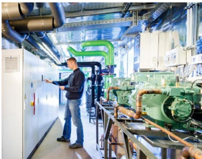
Chiller werden auch in Laboren oder Testanlagen eingesetzt, um Kaltwasser bereitzustellen, wie hier, rechts, in der Versorgungszentrale des Prüfstands für Kälte-, Klima- und Lüftungstechnik bei Tüv Nord.
