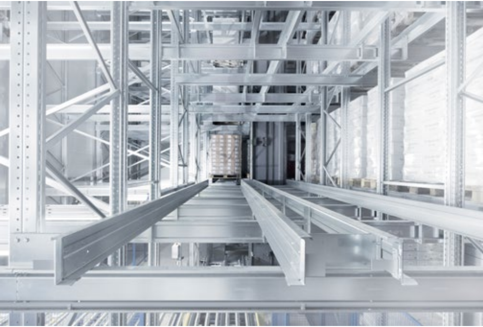
Die mehrfach tiefe Lagerung durch den Orbiter ermöglicht eine hohe Lagerdichte.
