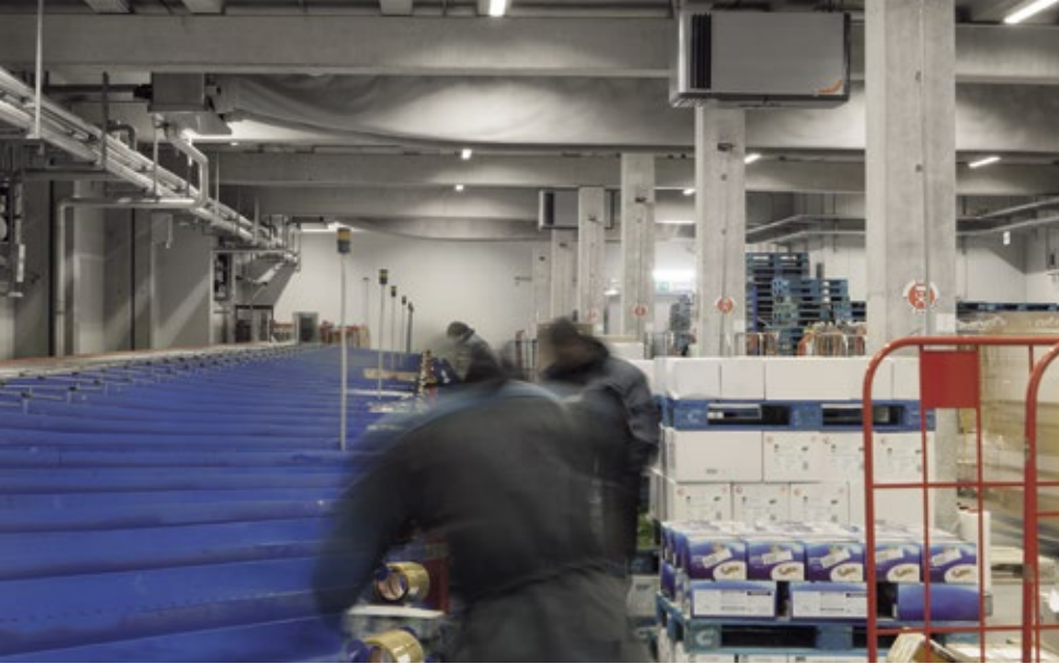
Sortieranlage, Förderbänder und allgemeine Infrastruktur hat Frigosuisse nach Installation der Luftreinigungssysteme seit sechs Monaten nicht mehr säubern müssen.
