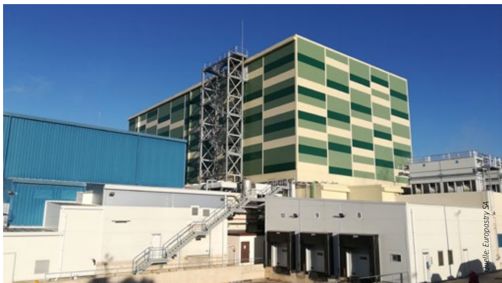
Am Produktionsstandort in Sarra hat Backwarenspezialist Europastry in eine neue Produktionsanlage samt automatisiertem Tiefkühlhochregallager investiert.
