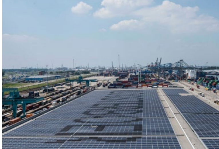
Das Tiefkühl-Hochhaus ist dafür ausgelegt, bei Bedarf bis zu 2700 Solarmodule für die Energieeigenversorgung zu tragen.
