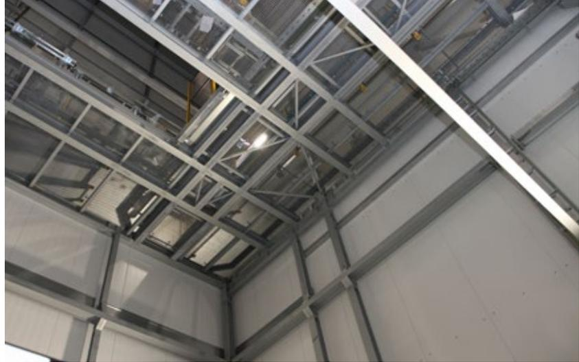
Das Tiefkühlager in Muggensturm wurde in Silobauweise errichtet. Das Regal zur Lagerung der Waren ist gleichzeitig das tragende Gerüst des gesamten Gebäudes, an dem auch die Außenfassade angebracht wurde.
