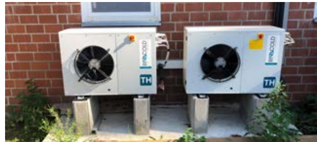
Zwei Rivacold Splitaggregate der Typen THUM und THCL zur Kühlung des Straußenfleischs.
