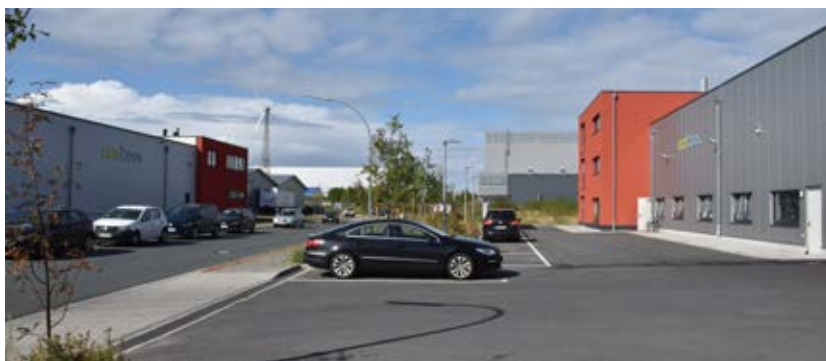
Auf dem Firmengelände von Ecocool in Bremerhaven hat sich in den letzten Jahren viel getan: 2015 konsolidierte das ursprünglich am Fischereihafen ansässige Unternehmen hier seine Produktion, die Büro- und Produktionsgebäude auf der rechten Seite sind im März 2022 dazugekommen.
