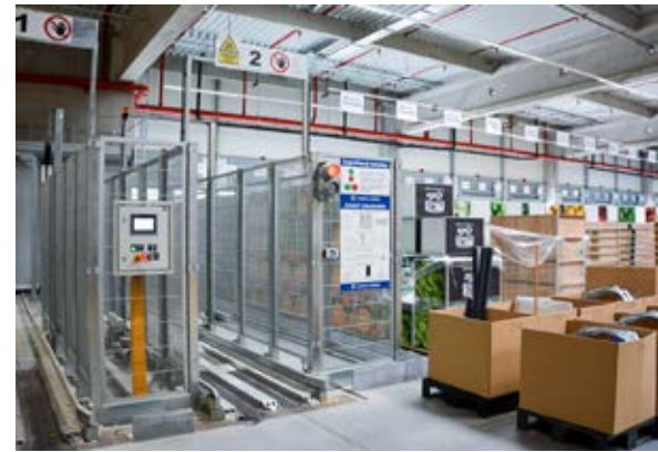
Im zweistöckigen Distributionszentrum werden beide Ebenen unter anderem über Expresslifte miteinander verbunden.
