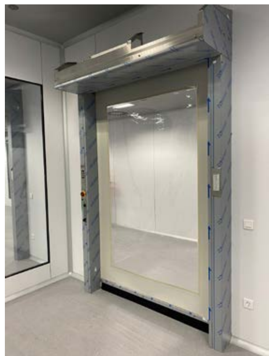
100 Reinraumtore EFA-SRT-CR hat das türkische Pharmaunternehmen Abdi Ibrahim in einem Erweiterungsbau verbauen lassen.
