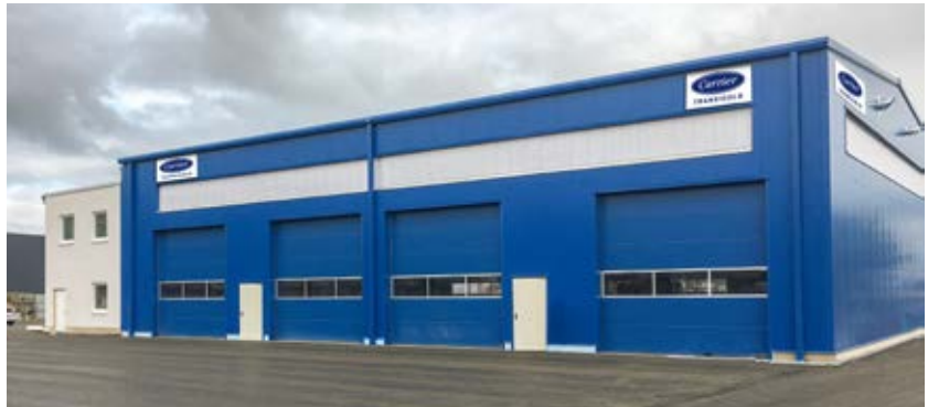
Das neue Carrier Transicold Service-Center Wildau liegt direkt an der A10.
